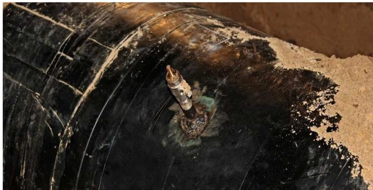
2. Врезка, представляющая собой полую трубу, закрепленную непосредственно в отверстии, выполненном в корпусе трубопровода или иного хранилища, не снабженную запорной арматурой. В зависимости от материала, из которого изготовлена данная труба, ток нефтепродуктов из нее перекрывается различными способами (перезжим, перетяжка, забивка чопом и т.д.);
