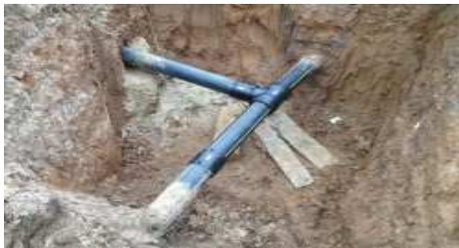
3. Врезка, представляющая собой приспособление, монтируемое непосредственно на отверстие в корпусе трубопровода или иного хранилища, снабженное специальной запорной арматурой (например шаровым краном), предназначенное для контролируемого слива нефтепродуктов, который осуществляется локально – в месте нахождения самой врезки. Такие врезки уже, как правило, выполняются в местах, затрудняющих их обнаружение, и маскируются в зависимости от типа хранилища и способа его залегания;
